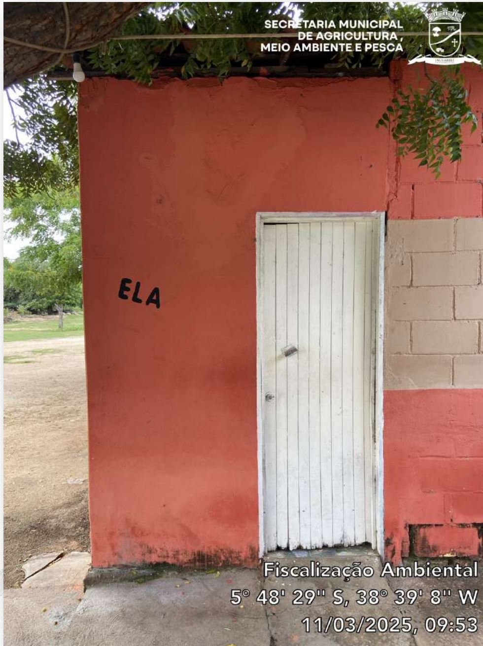
Figura 8 - Banheiro feminino da Barraca do Barto
