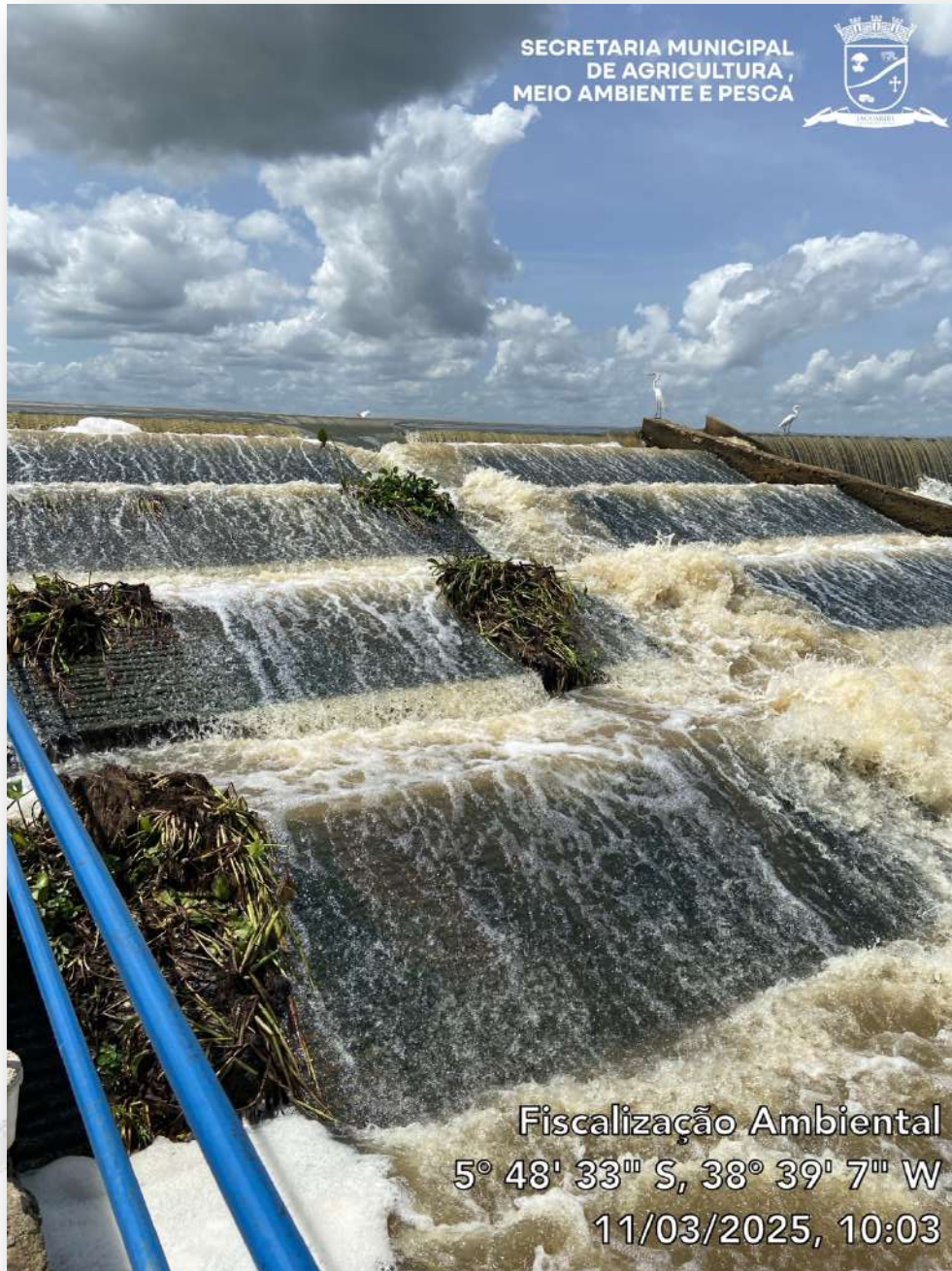
Figura 19 - Detalhes do STP do barramento, classificado como STP do tipo Escada ou Degrau, com descanso entre os degraus, sem ter sido identificada, por ocasião da vistoria, subida de peixes
