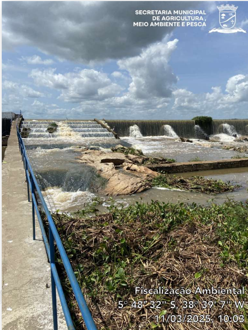
Figura 17 - Vista do Sistema de Transposição de Peixes (STP), localizado no Barramento da Barragem de Santana, ao lado do Balneário Barragem de Santana
