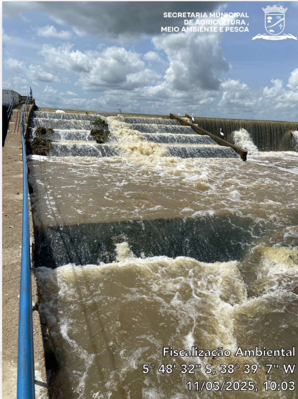
Figura 18 - Vista aproximada do STP
